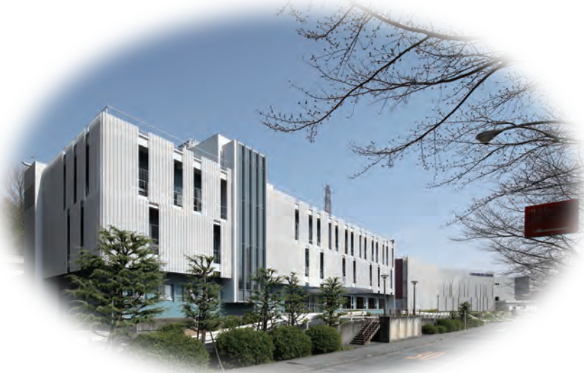
サイバーメディアセンター吹田本館
