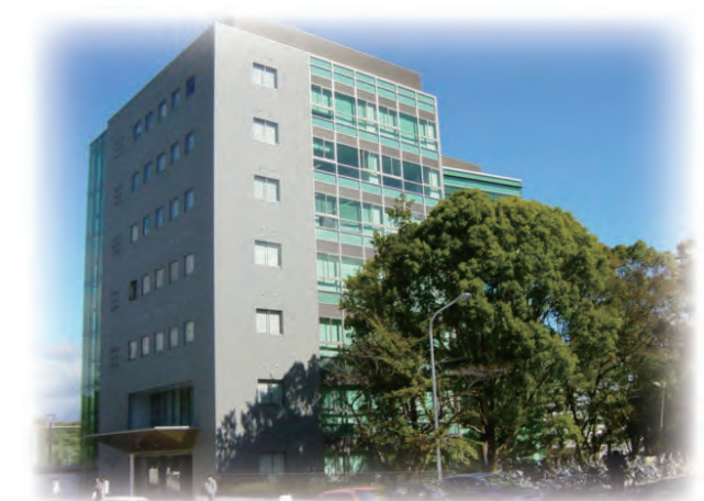
サイバーメディアセンター 豊中教育研究棟
