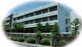
サイバーメディアセンター吹田本館
